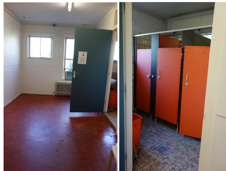
afb. 99 en 100 Zicht in ruimte G.7 (MAB, oktober 2018)
