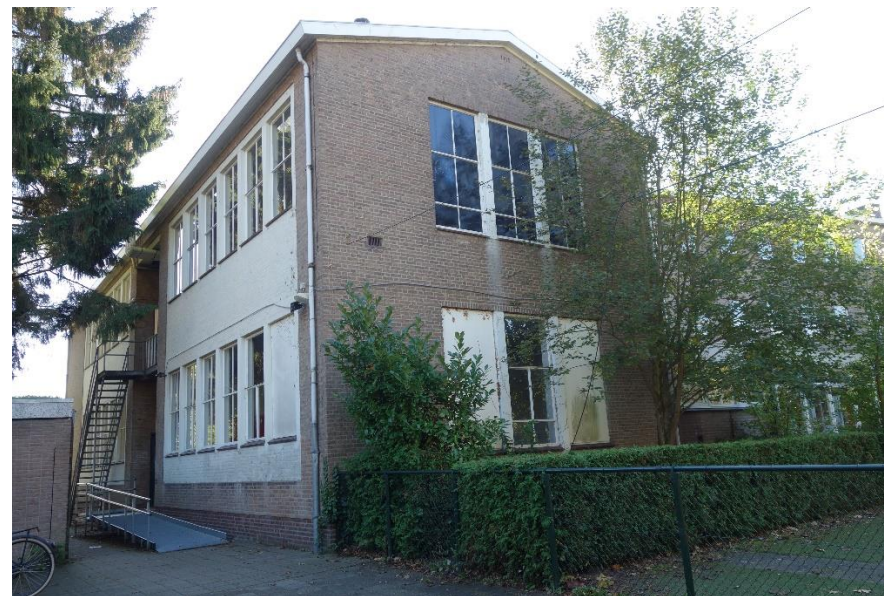
afb. 19 Zicht op de achtergevel en oostelijke zijgevel van de oostelijke vleugel, met enkele dichtgezette vensters. (MAB, oktober 2018)
