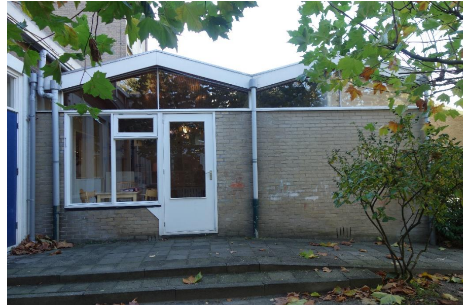
afb. 26 Zicht op de oostelijke zijgevel van de uitbouw uit 1967 (MAB, oktober 2018)
