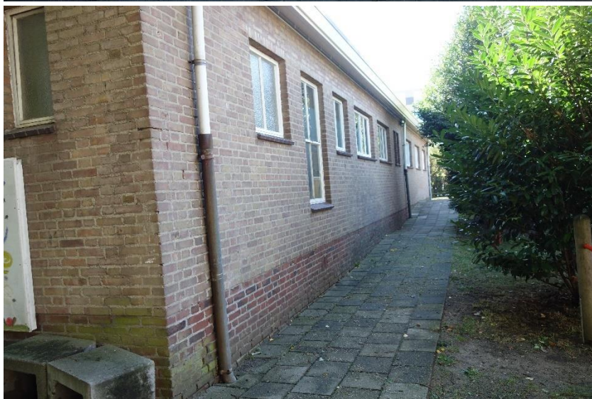
afb. 34 en 35 Zicht op de oostelijke gevel en de achtergevel (noord) van het gymlokaal met kleuterklas (MAB, oktober 2018)
