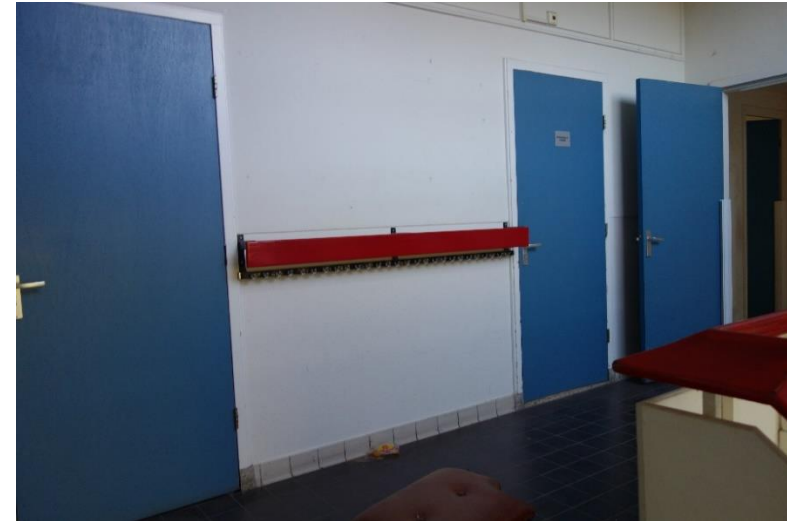
afb. 72 Zicht op de overloop van het hoofdtrappenhuis (1.2) (MAB, oktober 2018)
