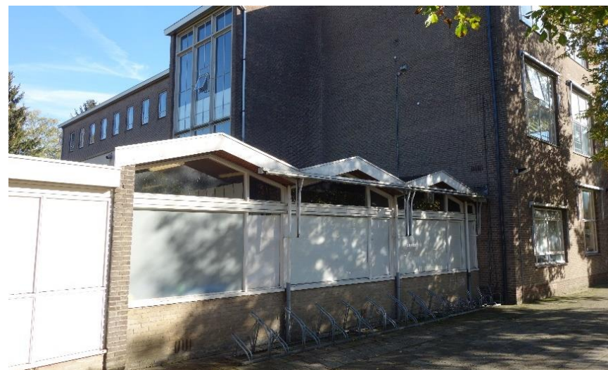
afb. 29, 30 en 31 Zicht op de westelijke gevel van de uitbouw uit 1967 (MAB, oktober 2018)
