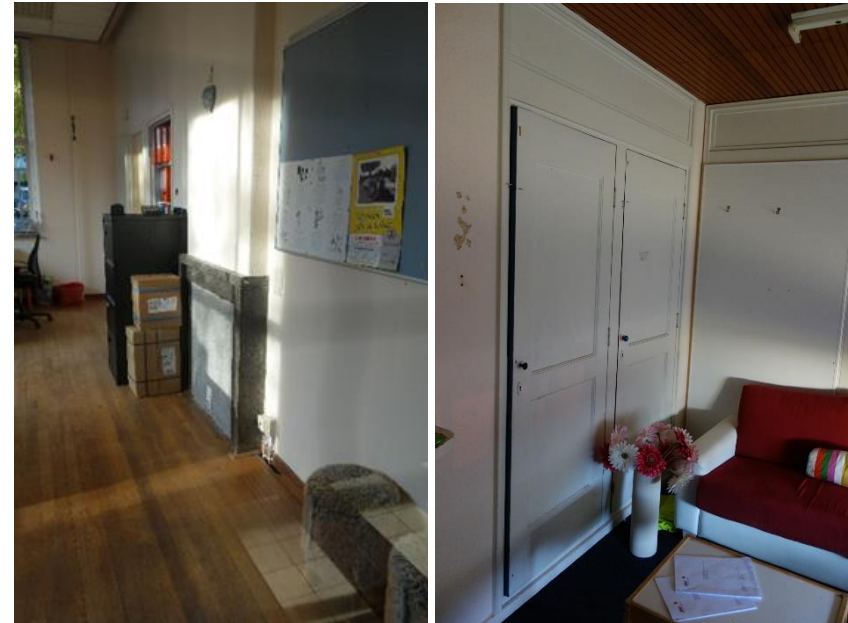
afb. 61 en 62 De schouw in de vm. directricekamer (0.6) en de vaste kasten in ruimte 0.9 (MAB, oktober 2018)
