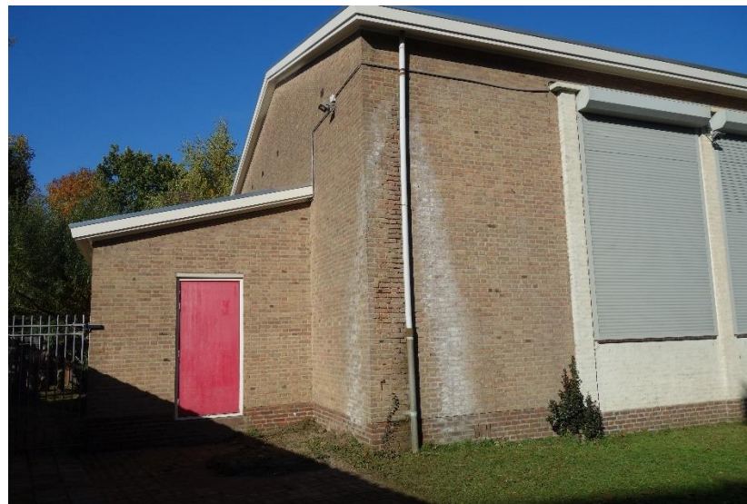
afb. 36 en 37 Zicht op de noordwestelijke en zuidwestelijke hoek van het gymlokaal met kleuterklas (MAB, oktober 2018)
