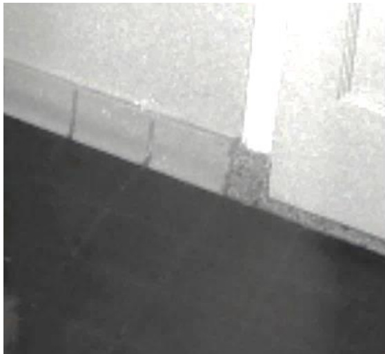
Detail van een historische foto uit 1969, waarop de zwarte tegelvloer, witte tegelplint en de granito dorpel met neuten duidelijk zichtbaar zijn. (CODA GA-041024)
