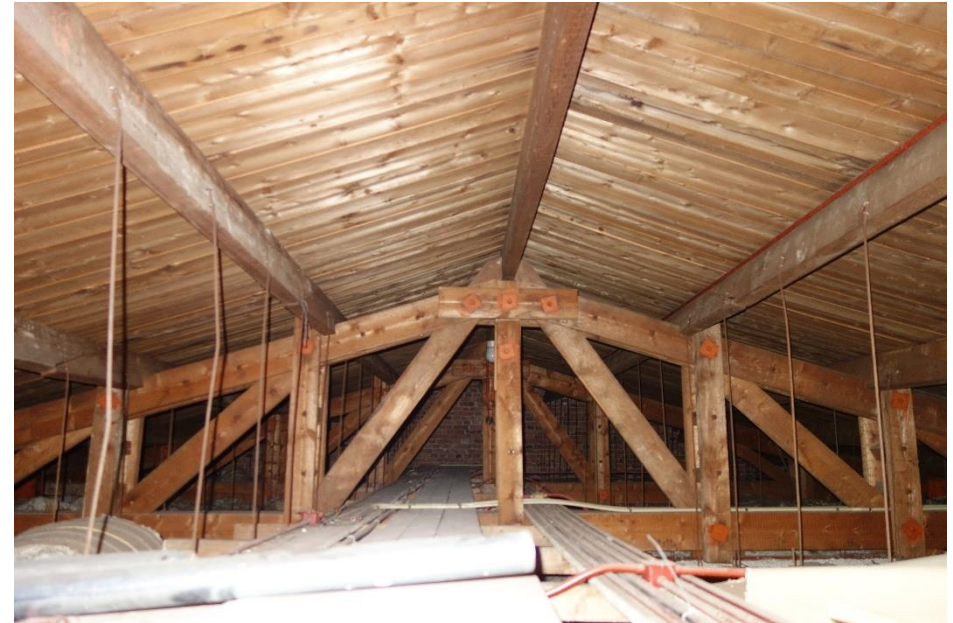
afb. 38 Zicht in de kap van de oostelijke vleugel van de school. Het is zeer aannemelijk dat dezelfde kapconstructie is toegepast in de hoofdbouw (MAB, oktober 2018)
