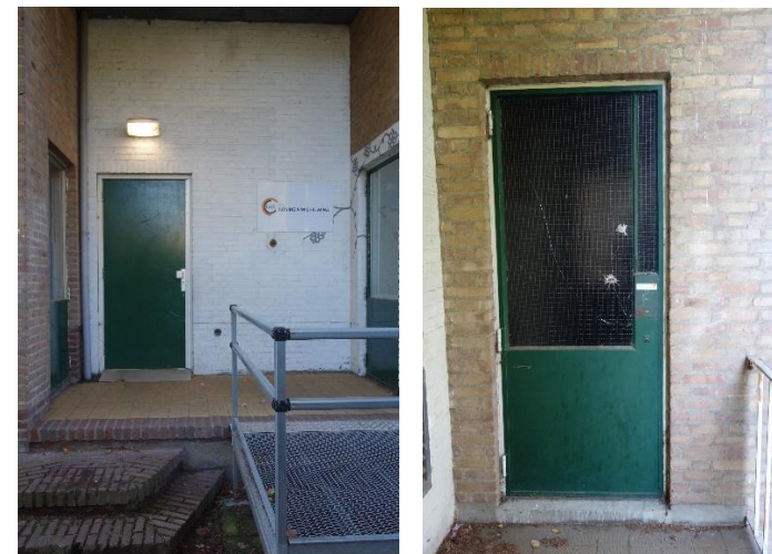
afb. 15 en 16 Detail van de oostelijke zijgevel met stalen deuren vanuit de lokalen (MAB, oktober 2018)
