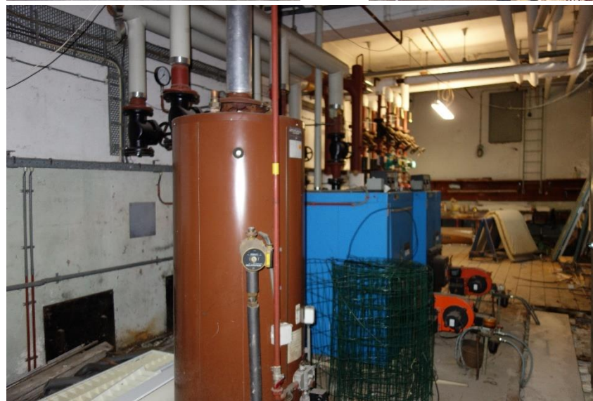
afb. 46, 47 en 48 Zicht in kelder A (MAB, oktober 2018)
