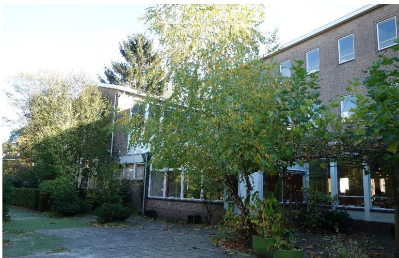
afb. 23 Zicht op de achtergevel van de school, met geheel links de oostelijke vleugel en de uitbouw uit 1992 (MAB, oktober 2018)
