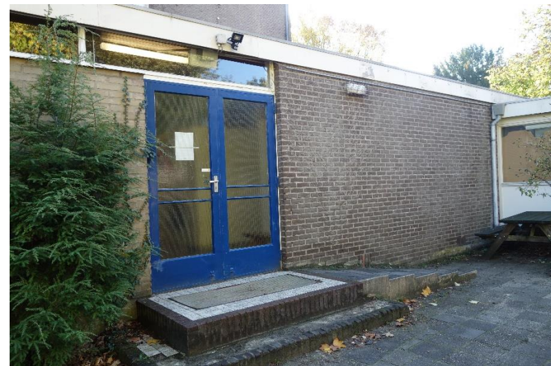
afb. 27 Rechter deel van de achtergevel van de uitbouw uit 1967 (MAB, oktober 2018)
