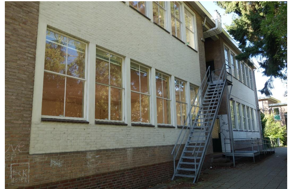
afb. 14 Zicht op de oostelijke zijgevel van de oostelijke vleugel (MAB, oktober 2018)
