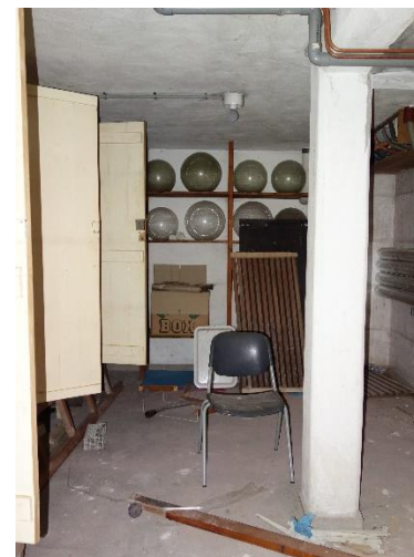
afb. 49, 50, 51 en 52 Zicht in kelder B (MAB, oktober 2018)
