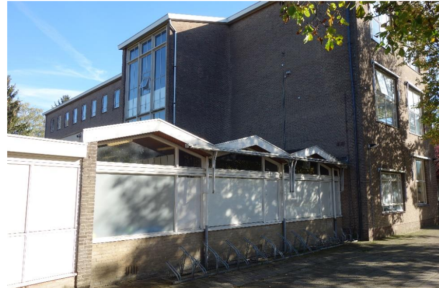
afb. 20 Zicht op de achtergevel van de hoofdbouw, gezien vanaf het terrein voor de gymzaal. Op de voorgrond de uitbouw uit 1967. (MAB, oktober 2018)
