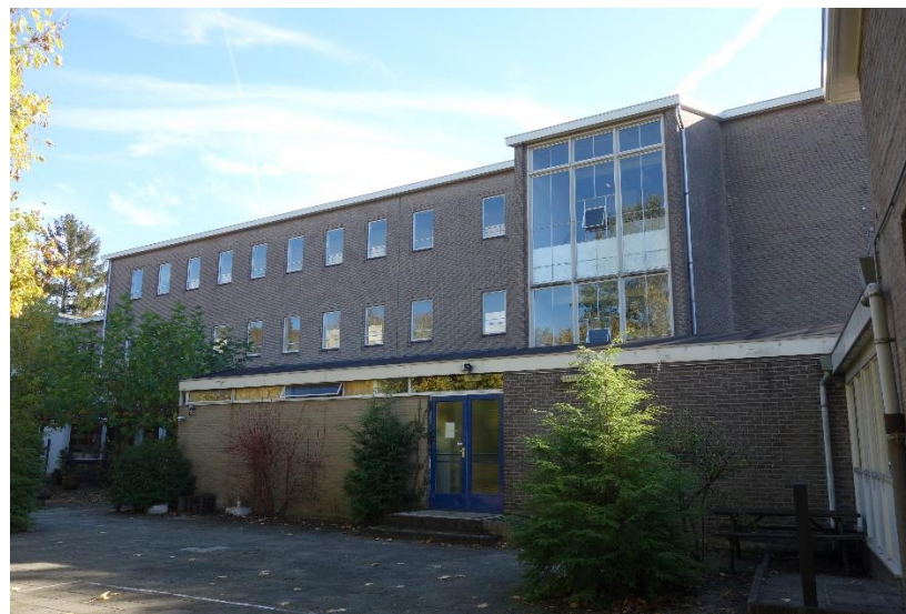
afb. 24 Zicht op de achtergevel van de hoofdbouw met de uitbouw uit 1967 (MAB, oktober 2018)
