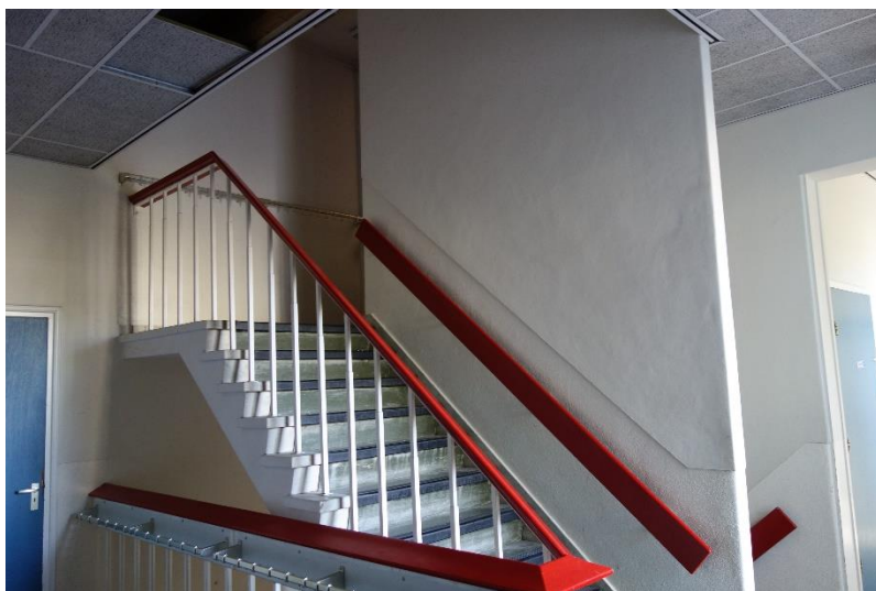
afb. 79 Het secundair trappenhuis (1.9) (MAB, oktober 2018)
