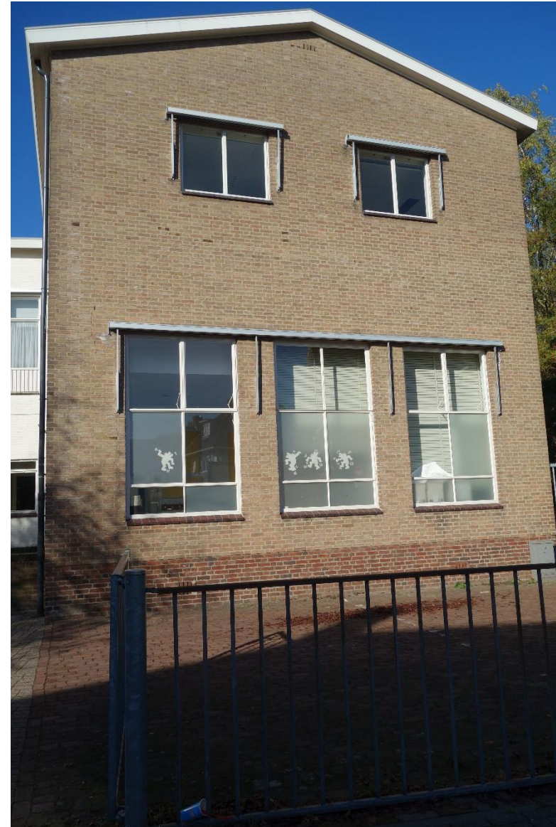
afb. 10 Zicht op de zuidelijke kopgevel van de oostelijke vleugel (MAB, oktober 2018)
