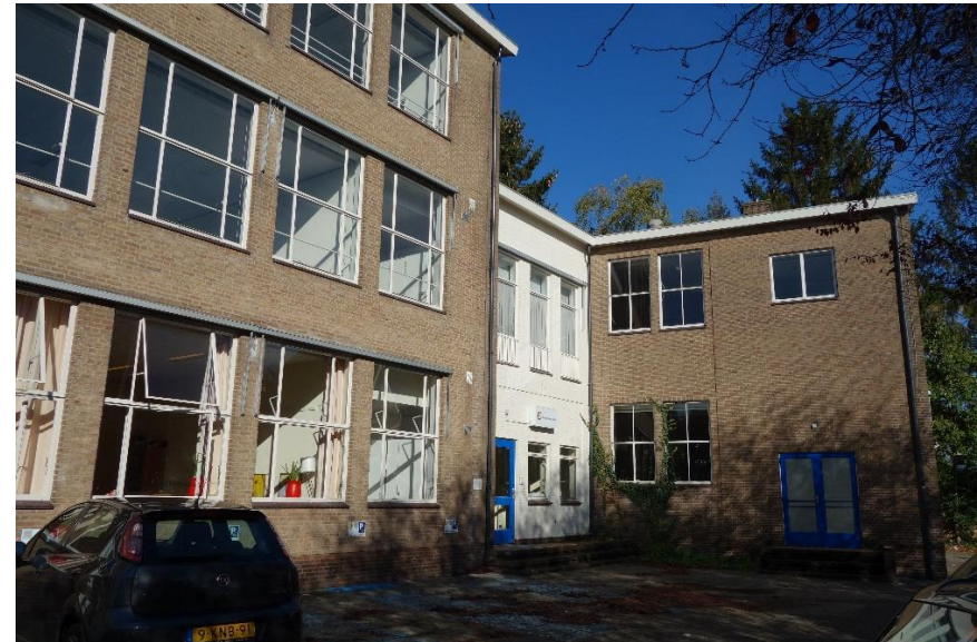
afb. 9 Zicht op de oostelijke vleugel en de verbinding met het hoofdgebouw (MAB, oktober 2018)
